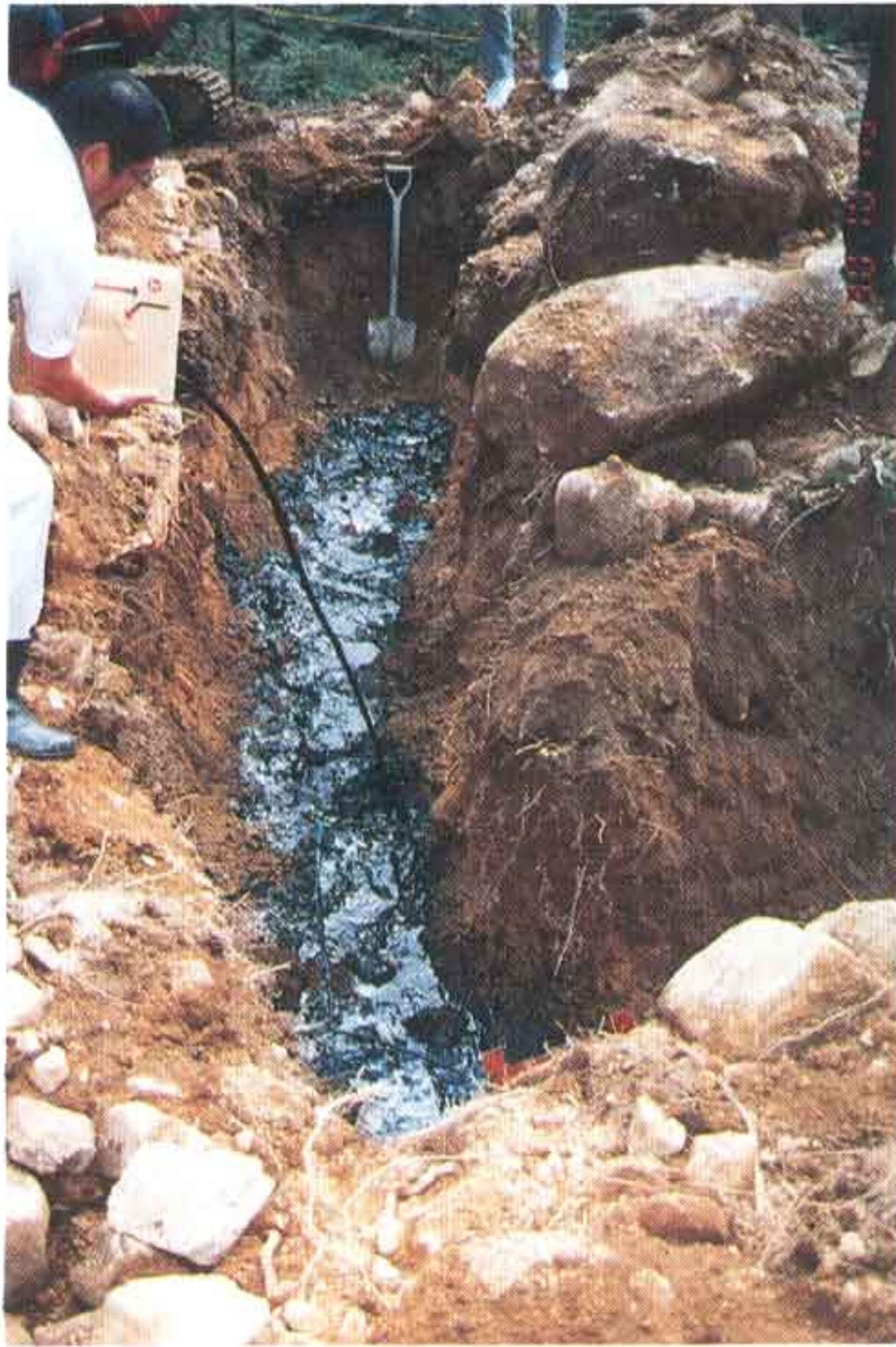
柯洛伊德 ( Colloid Carbon ) 散布 作業
