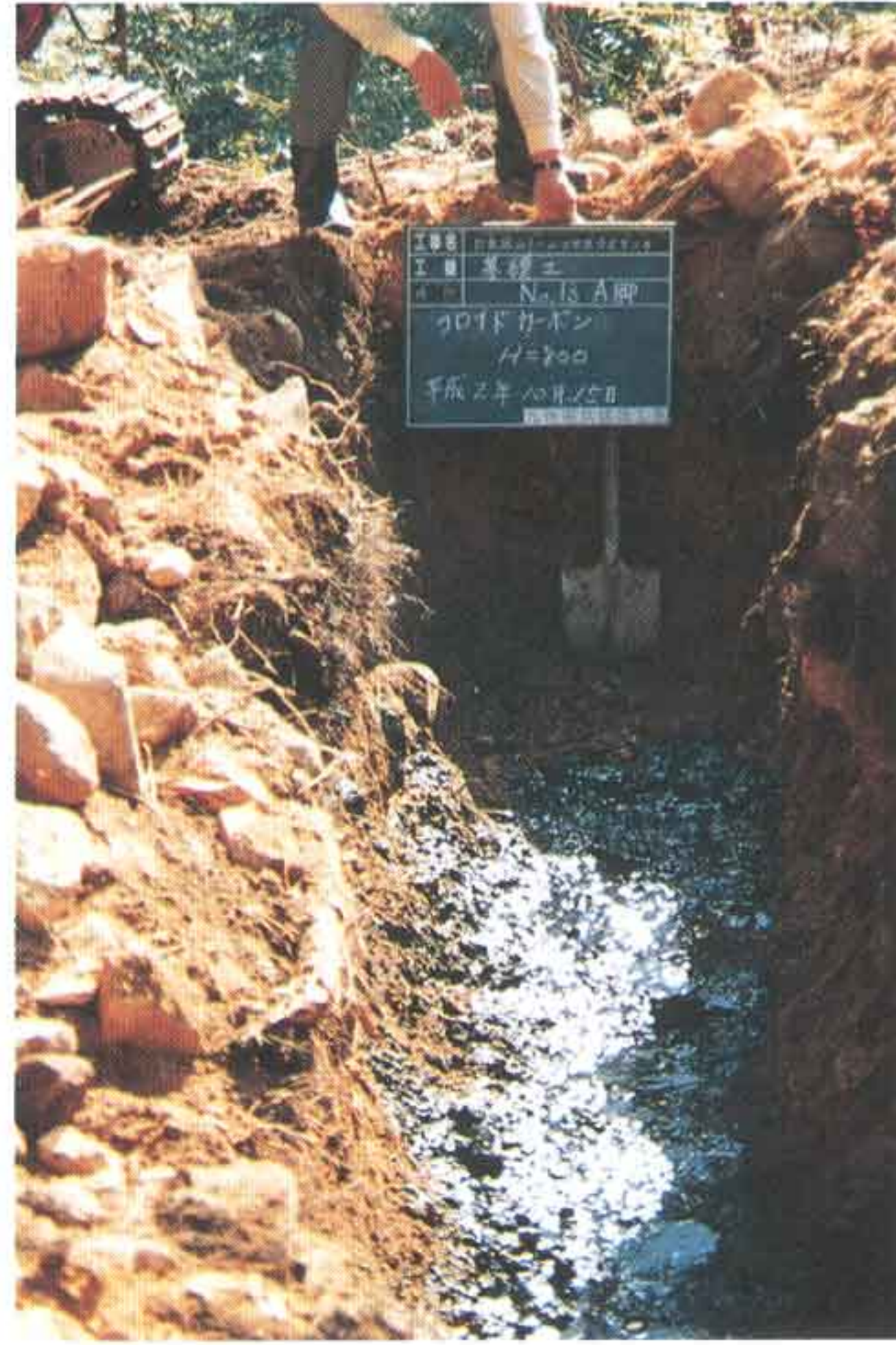
柯洛伊德 ( Colloid Carbon ) 散布 作業完成
